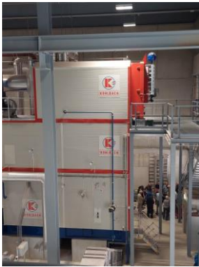
Abbildung 4: Schnitzelofen mit Wärmetauscher (oberster Teil), Foto: M. Gisler
