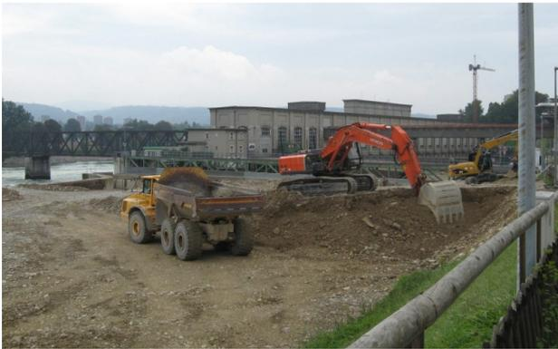
Der alte Kanal zu den Turbinen des alten Kraftwerkes wird für die Renaturierung vorbereitet.
